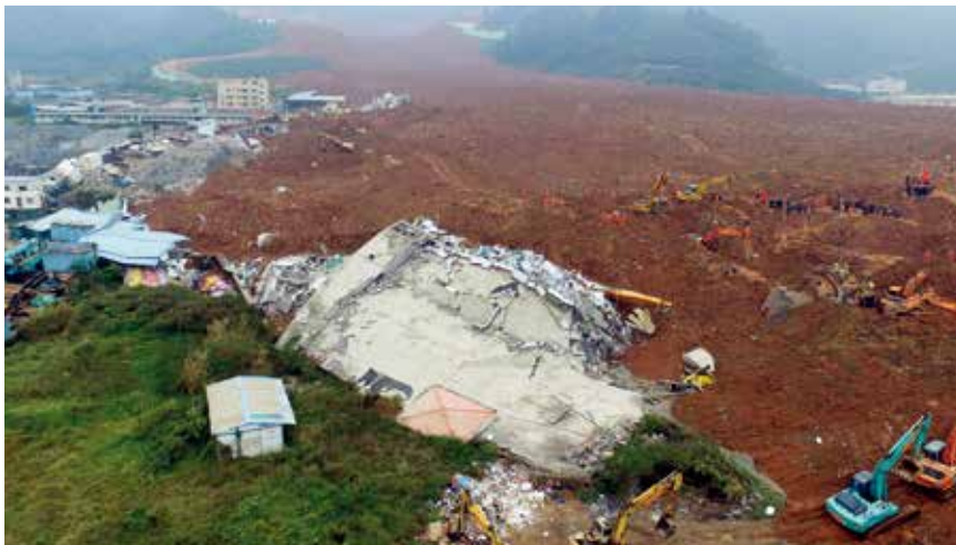
2015年12月21日，广东深圳，深圳市光明新区凤凰社区滑坡现场。图为航拍的滑坡现场画面。供图/视觉中国
