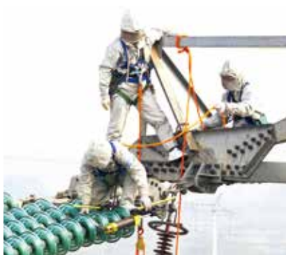
2016年12月5日，无人机航拍的带电作业工在40米高空超高压电塔上作业的场景。供图/国家电网
