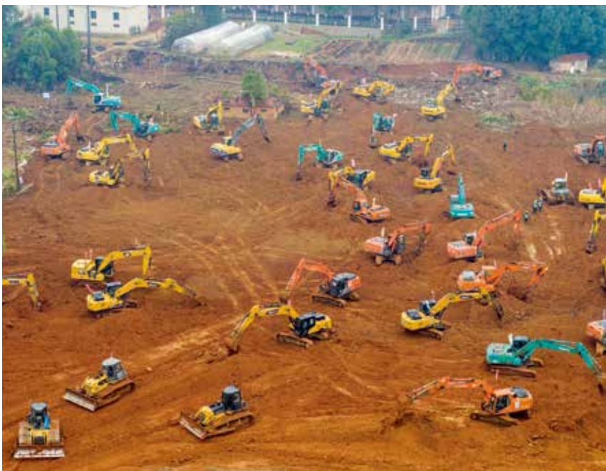
1月23日，武汉版“小汤山”——火神山医院施工现场。 供图/视觉中国
